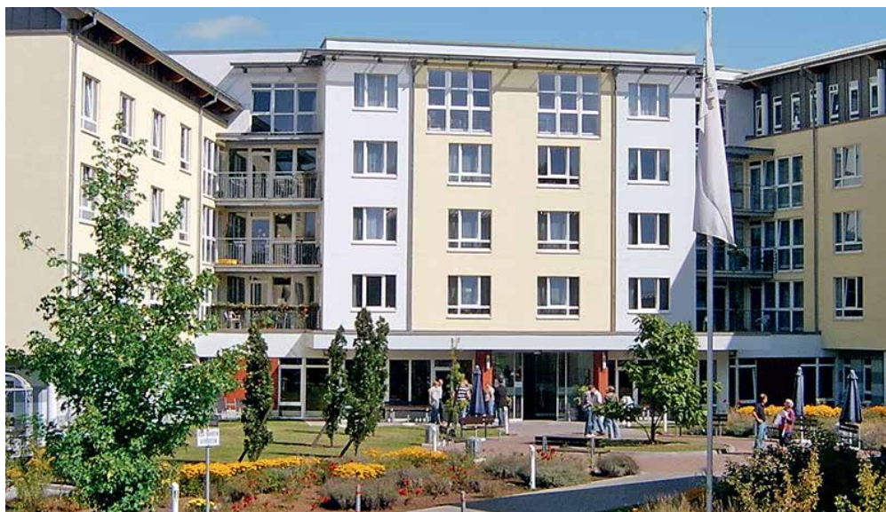
Energiepartnerschaft in Kaiserslautern – Seniorenzentrum des DRK-Landesverbands Rheinland-Pfalz
