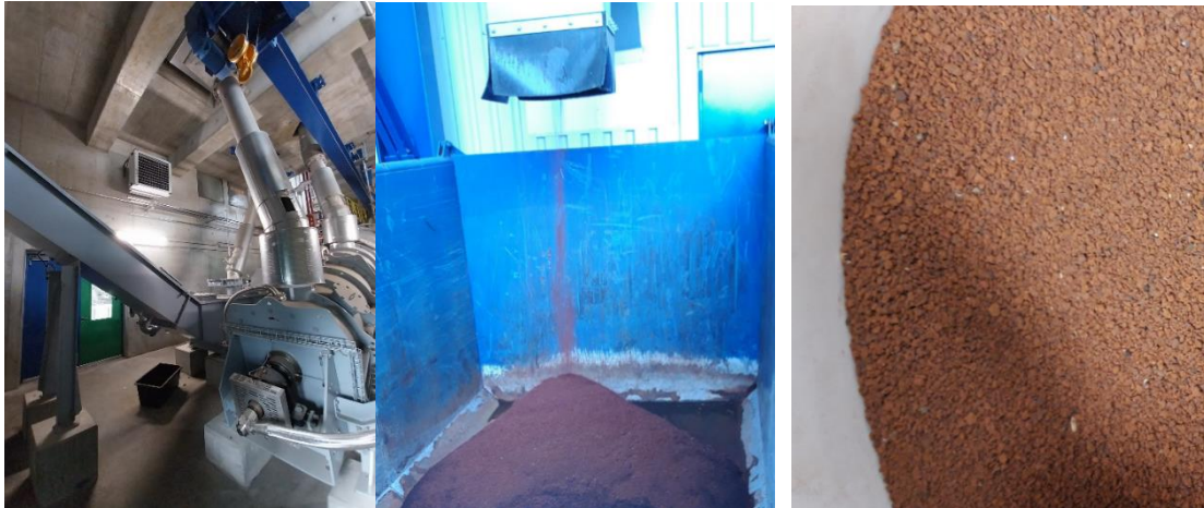
Aufnahmen 2,3 und 4: Asche-Austragssystem und -Abwurf, Ascheprobe
