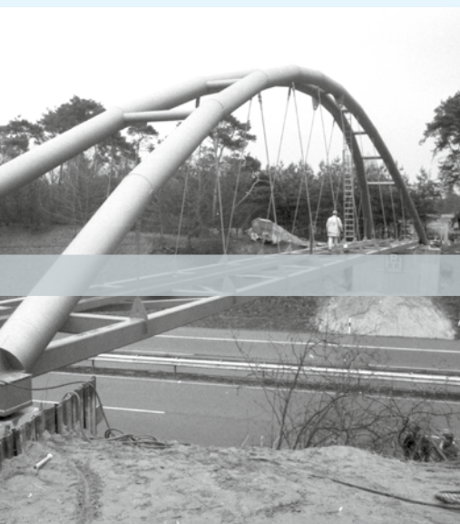
Fernwärmerohrverlegung über B65
