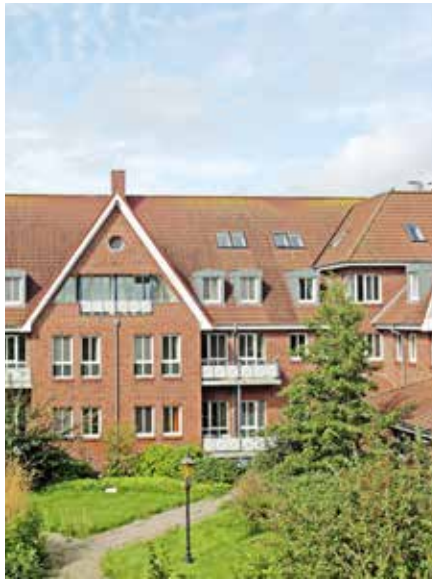
Das DJH Resort Neuuharlingersiel geht mit Energieliefercontracting neue Wege.
