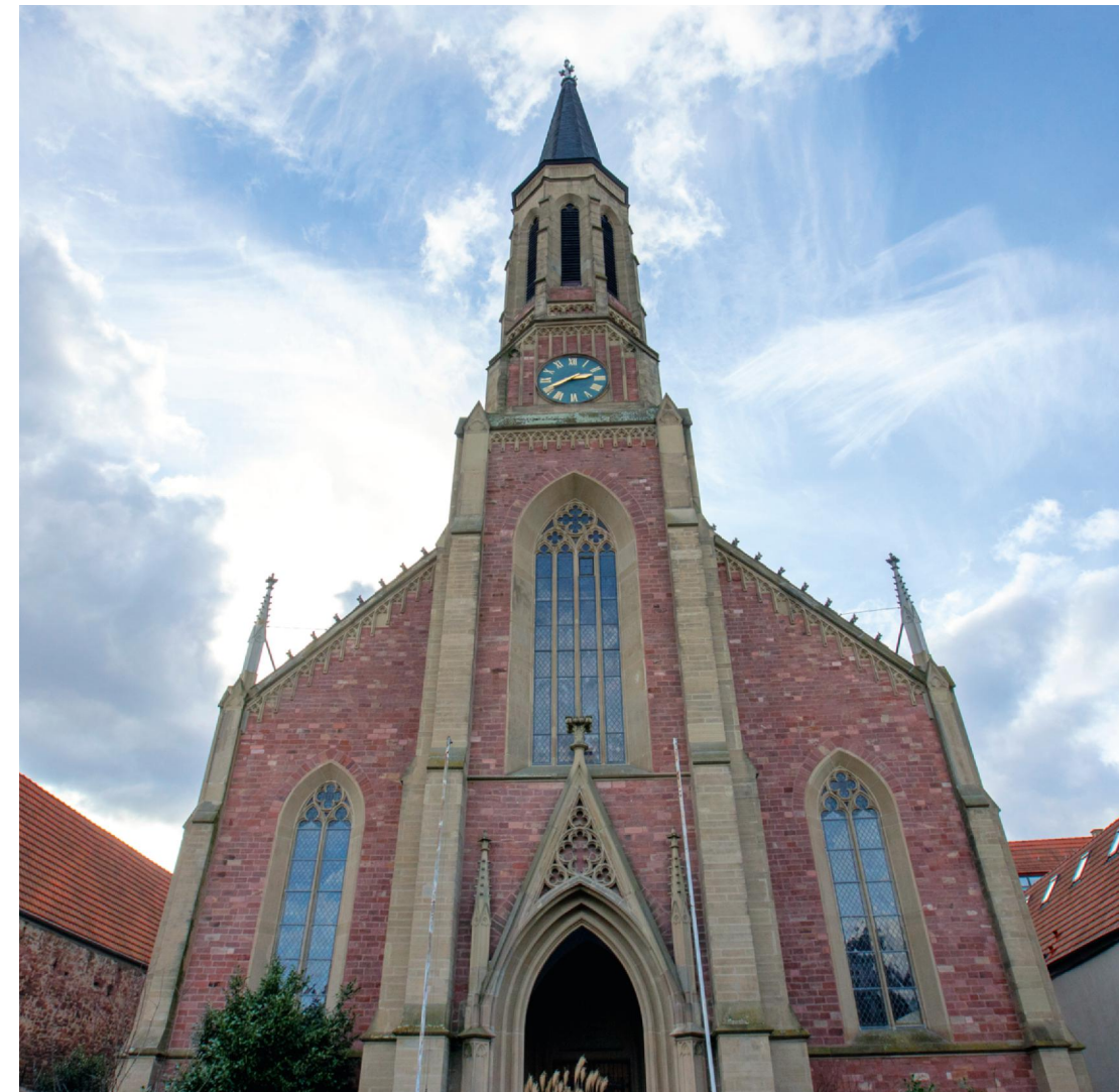
Die Erlöserkirche Seckenheim ist eine von zehn Mannheimer Kirchen, die mit Gateways zur Datenübertragung ausgerüstet wurden
